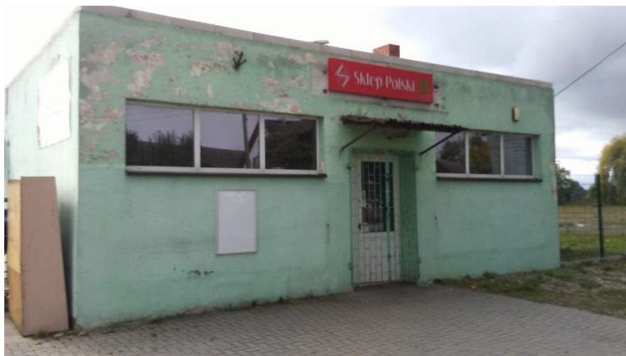
Zdjęcie zakupionego budynku wykonane przed remontem.
