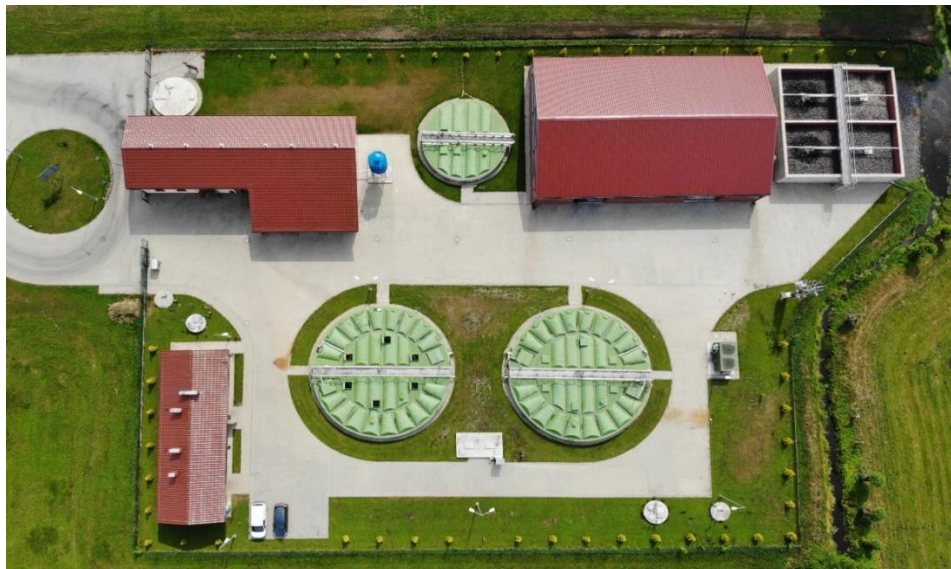
Widok oczyszczalni ścieków z lotu ptaka.
