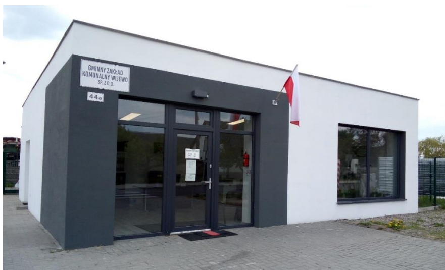
Zdjęcie budynku wykonane po remoncie.
